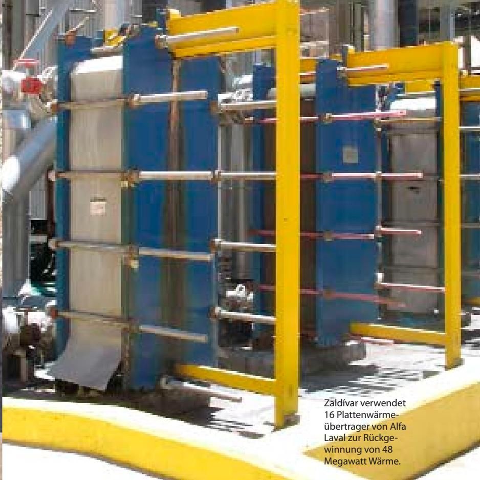
Zaldívar verwendet 16 Plattenwärmeübertrager von Alfa Laval zur Rückgewinnung von 48 Megawatt Wärme.
