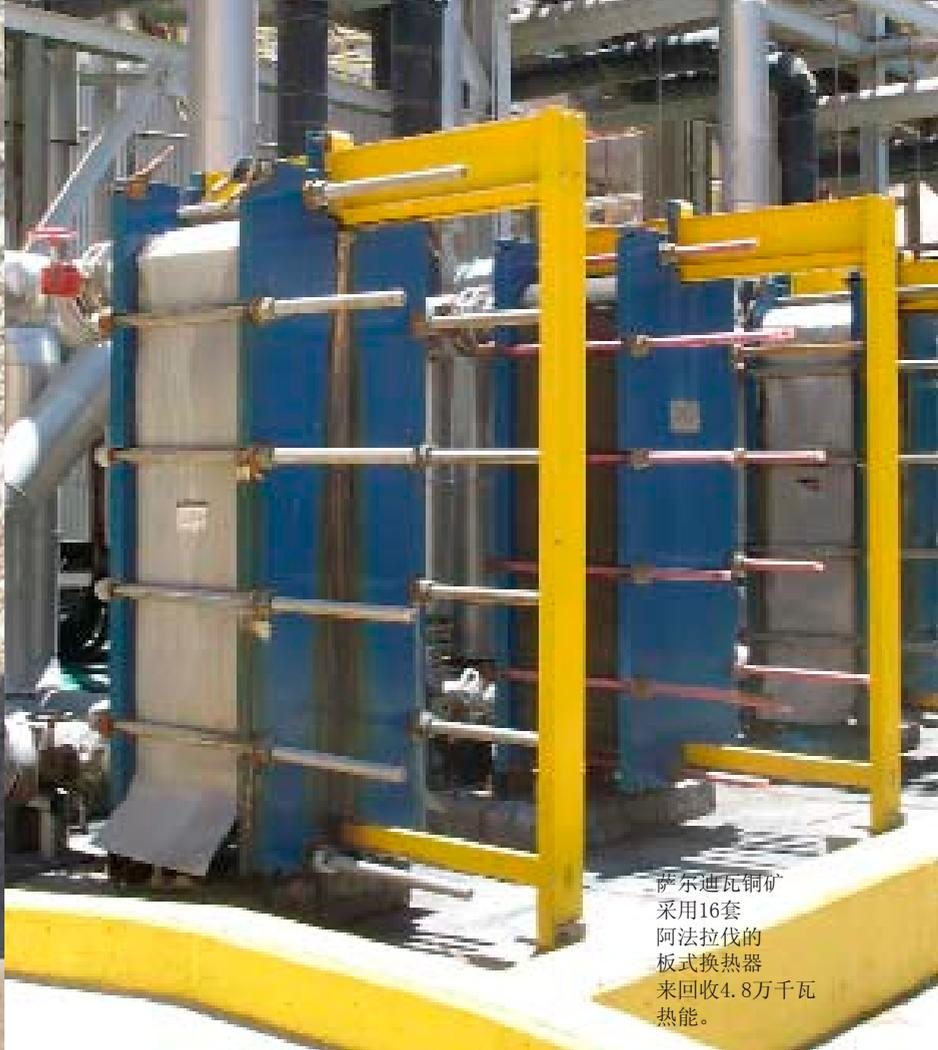
萨尔迪瓦铜矿采用16套阿法拉伐的板式换热器来回收4.8万千瓦热能。
